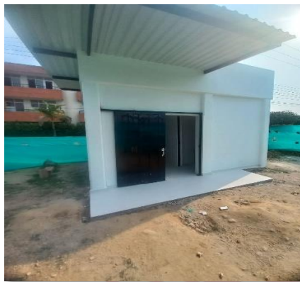
Construcción de unidades sanitarias para placa
