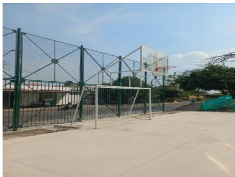
Construcción en malla nylon para cerramiento perimetral placa polideportiva el sabañón barrio Buenos Aires
