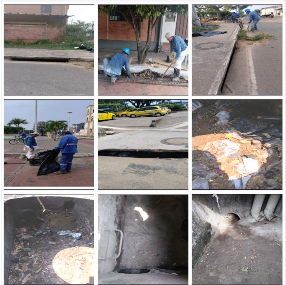
Actividades de los fontaneros del sistema de alcantarillado durante el periodo ejecutado. (limpieza de pozos de inspección y sumideros)
