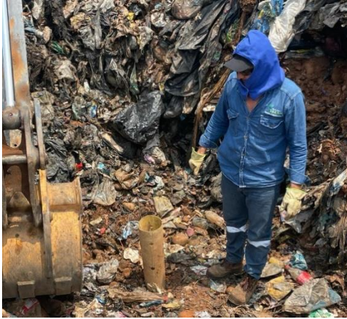
Durante el proceso de excavación
