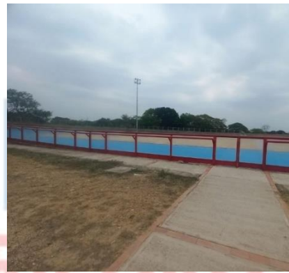
Mantenimiento y puesta en funcionamiento del patinódromo
